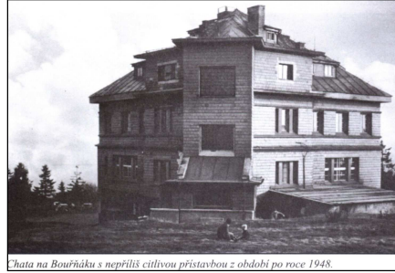
Chata na Bouřňáku s nepřiléhá cítilnou přístavbou z období po roce 1948.
